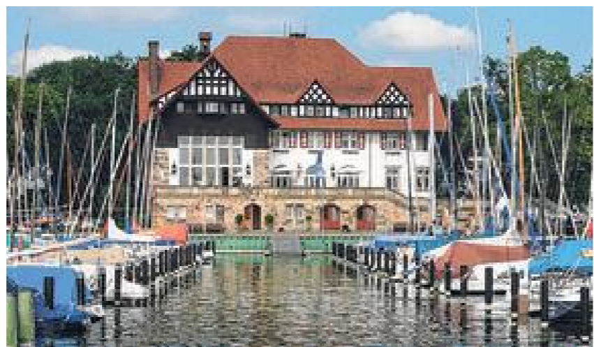
Zukunft als gelebte Herkunft: Im Seglerhaus am Wannsee hat sich in den letzten 107 Jahren nur wenig geändert. Heute steht es unter Denkmalschutz
